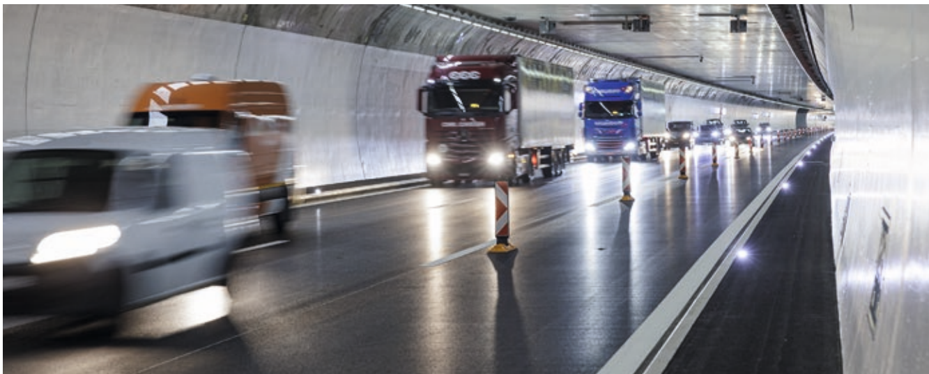
La terza canna della galleria del Gubrist, prezzo Zurigo, è stata inaugurata ad aprile 2023.
