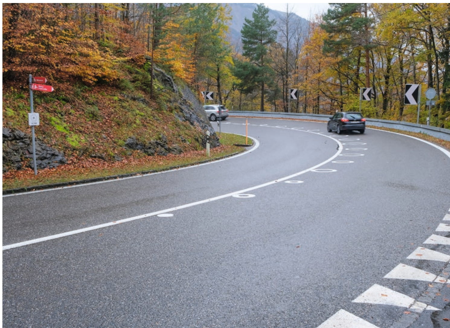
I cerchi tracciati sull'asfalto aiutano a leggere le traiettorie sulla strada del passo del Brünig.
