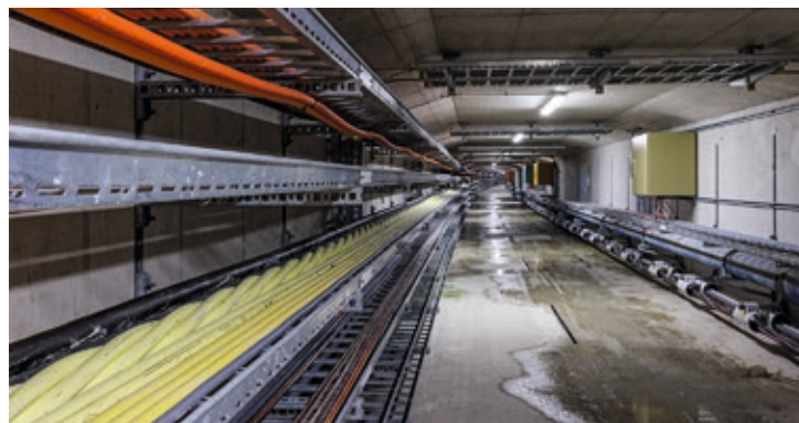
Il canale tecnico della terza canna della galleria del Gubrist: l'interruzione delle catene di fornitura dei materiali speciali può danneggiare installazione e avanzamento lavori.
