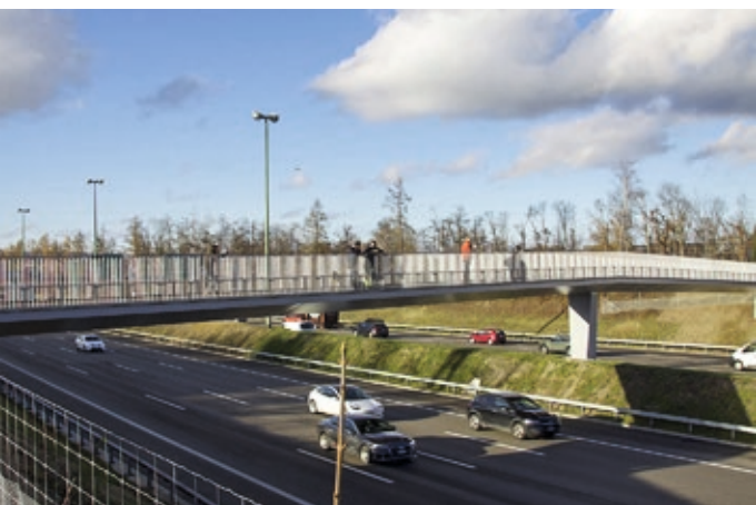
Il sovrappasso ciclopedonale sull'autostrada A1 presso Oberwies/Wallisellen (ZH).
