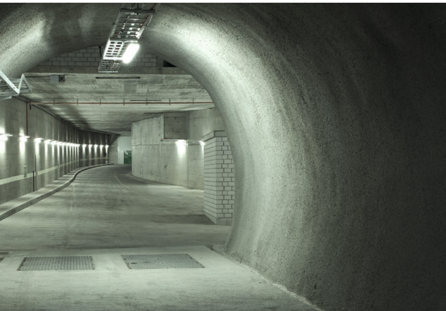
Il cunicolo di sicurezza della galleria Milchbuck a Zurigo.
